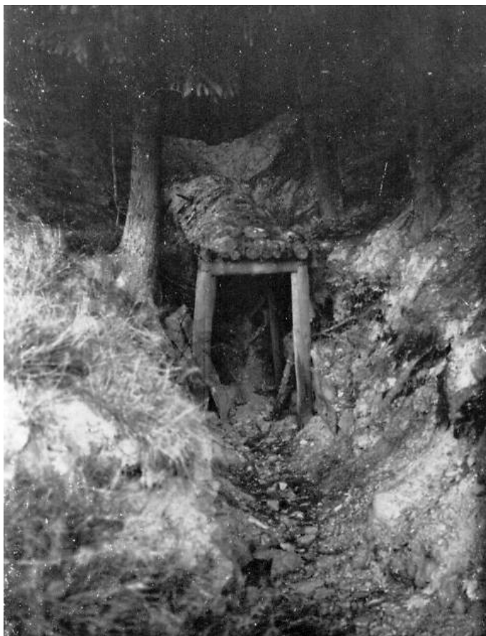
Mundloch des Sonnenberger tiefen Stollens um 1960 (Foto: Hans Schmidt).
